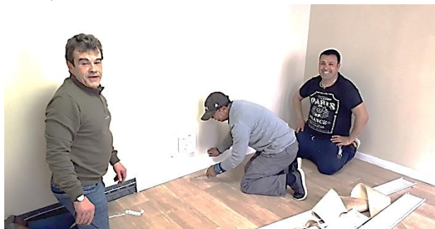
Travaux de la Salle 'Jardin biblique'
